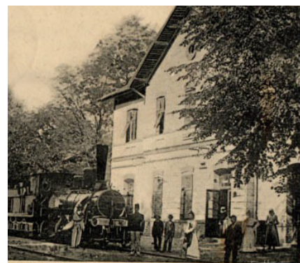
A vasútállomás épülete egy beálló tehervonattal
