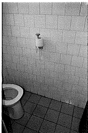
wc, mosdó - alagsor
