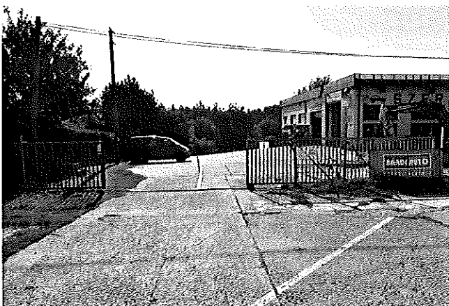
20/ 5 hrsz ingatlan bejárata
