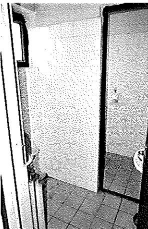
wc, mosdó - alagsor
