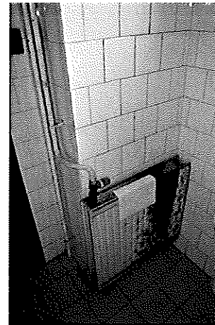
wc, mosdó - alagsor
