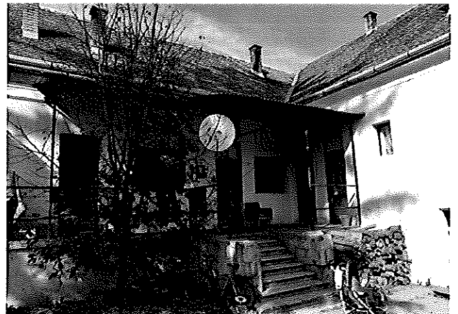
társasház udvari képe
