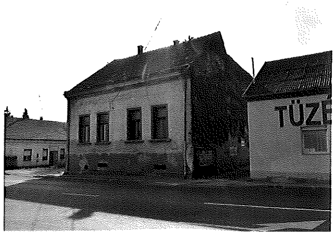
társasház utcai képe
