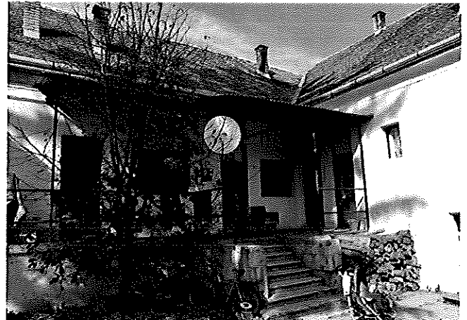
társasház udvari képe
