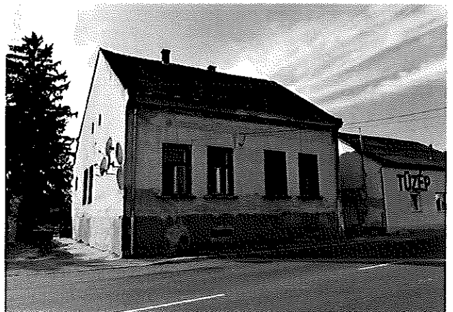
társasház utcai képe
