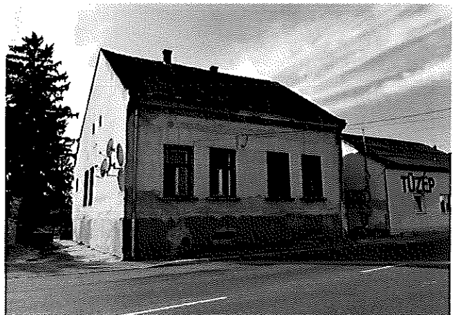
társasház utcai képe
