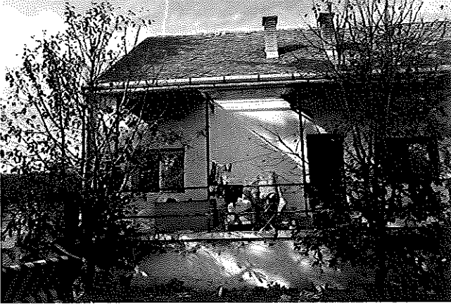
társasház udvari képe
