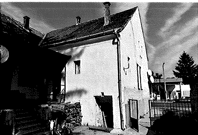
társasház udvari képe
