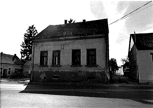
társasház utcai képe
