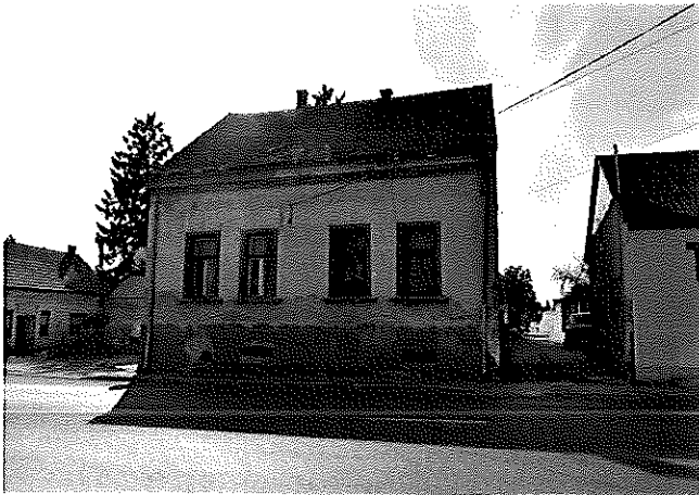
társasház utcai képe
