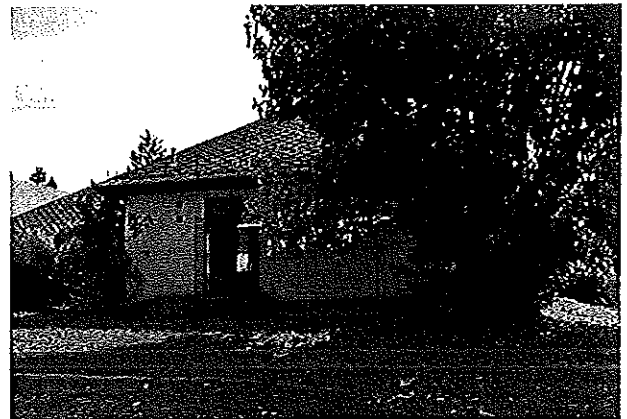
Ny-i épületrész udvari homlokzata
