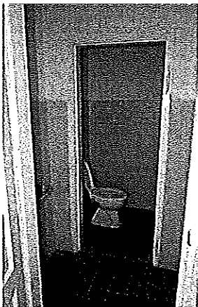
előtér, wc - keleti épületrész
