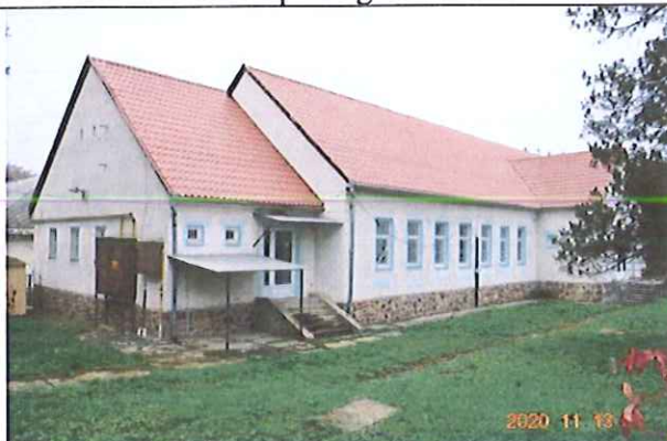
Utcafronti épületrész D-K-i homlokzata
