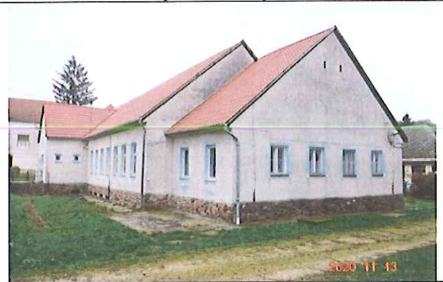
Utcafronti épületrész É-K-i homlokzata
