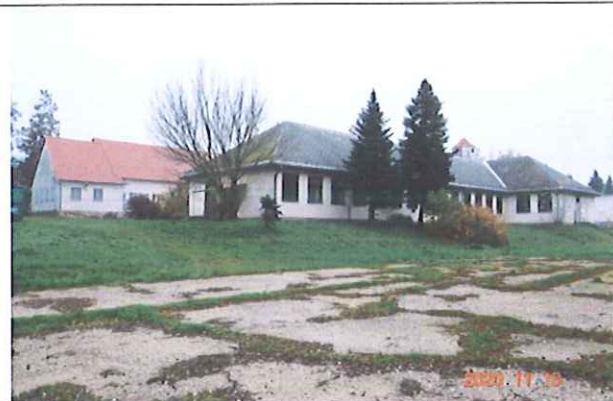
Udvari épületrész É-Ny-i homlokzata
