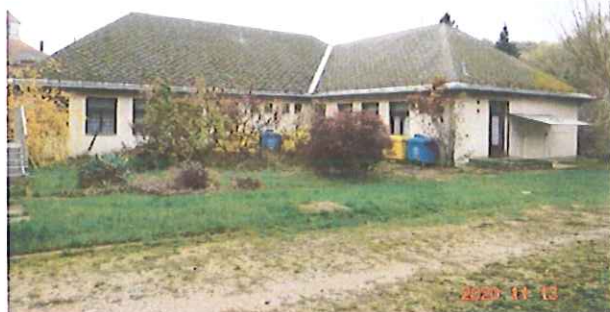
Udvari épületrész É-i homlokzata
