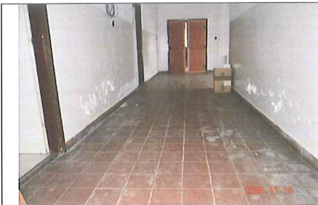
Folyosó látható vizesedés
